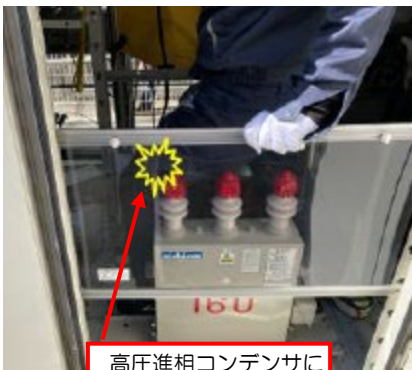
高圧進相コンデンサに 接触し感電（推定）
