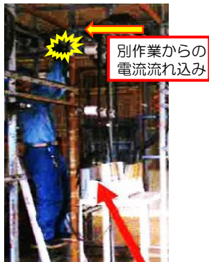
交換作業中に断路器に触れ感電
