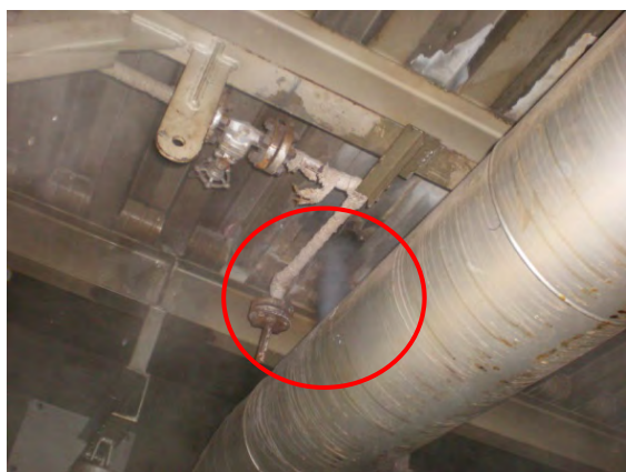
↑（東京都杉並区）【震度 5 弱地域】 ・ ボイラー最上部の主蒸気連絡管空気抜き管が破損し蒸気漏れ発生
