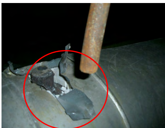
↑（東京都杉並区）【震度 5 弱地域】 ・ ボイラー最上部の主蒸気連絡管空気抜き管が破損し蒸気漏れ発生
