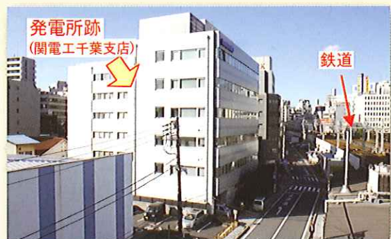
写真4 千葉発電所跡(現・関電工千葉支店) 南東方向から撮影
