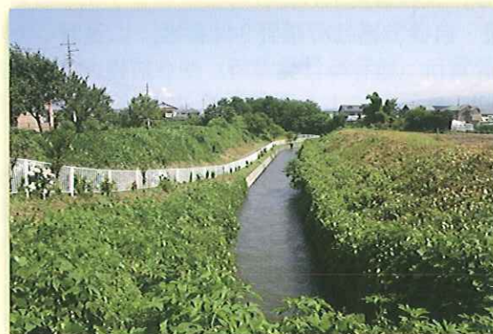
図3 天狗岩用水（立石橋の約200m上流） 開削部で、左側の白い柵は昭和63年（1988）の水路改 修に合わせ整備された管理用道路です。遊歩道として開 放されています。
