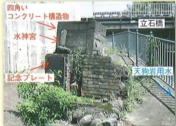
写真1 植野発電所の取水口の遺構
