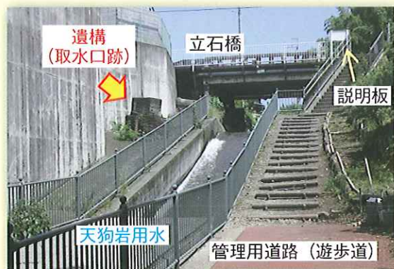
写真2 植野発電所 取水口跡 発電所は左側のコンクリート擁壁側にありました
