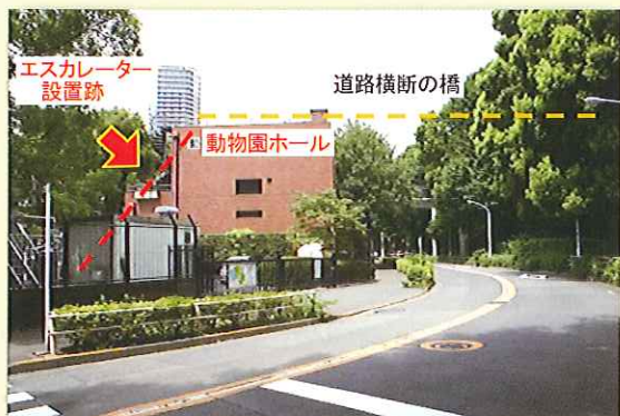
写真2 エスカレーターの設置場所
