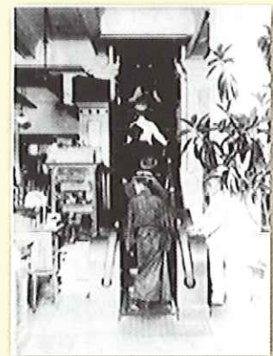
写真5 三越のエスカレーター (株)三越伊勢丹提供
