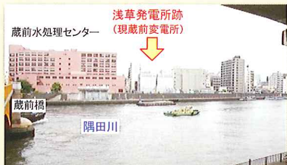
写真2 隅田川対岸よりの浅草発電所跡 写真1とほぼ同じアングル
