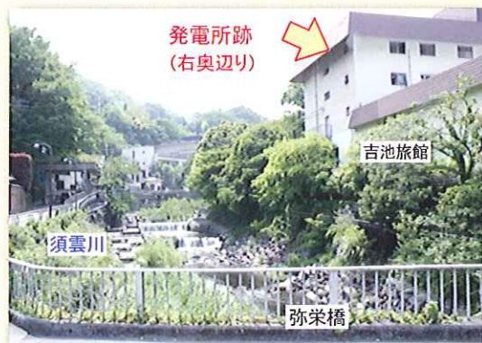
写真4 須雲川の流れ(弥栄橋から上流を撮影) ・川の流れは急で階段状に流れていて、この落差を利用して発電していたと推察されます。 ・取水口は、この上流にありました。
