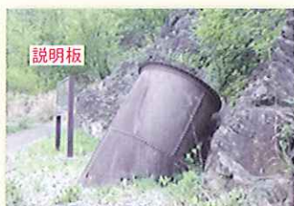
写真2 水圧鉄管の一部と上部水槽跡
