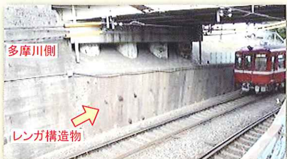
写真3 六郷橋駅跡 橋脚部に残るレンガ構造物
