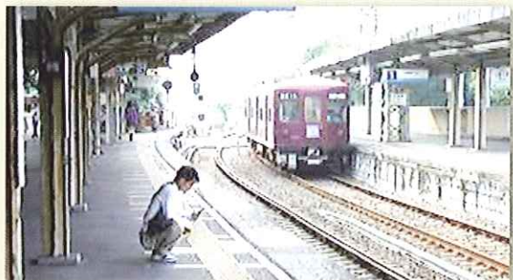
写真4 川崎大師駅ホーム 京急川崎駅方向
